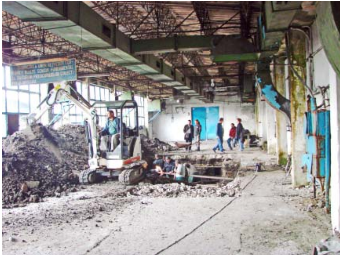
Aspect din timpul săpăturilor executate cu mijloace manuale și mecanice (2012)
